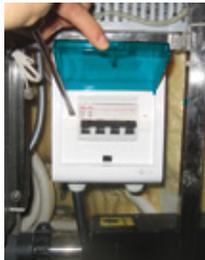
A l'aide d'un tournevis, dévisser les vis pour libérer le couvercle du boîtier et accéder au câblage du boîtier.
